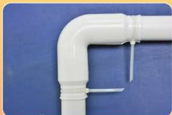
⑥ 可選用束線止帶，將束線止帶繫於另件的溝槽口，並拉緊封口完成施作。
