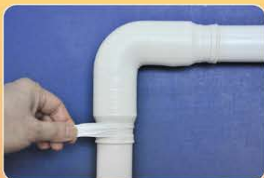
⑤ 可選用膠帶，以保溫膠帶形式進行纏繞至整個外緣，並注意平整度完成施作。
